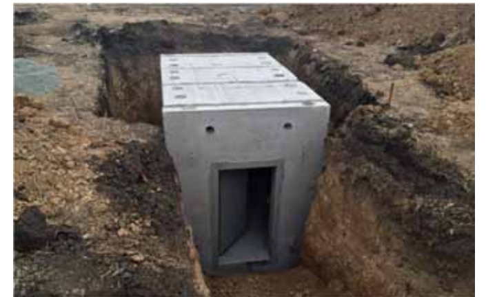
Фото 3. Типове укриття в процесі будівництва. (Фото з сайту Думская. http://dumskaya.net/news/oga-pokazala-kak-odesskie-kompanii-stroyat-ukrep-046783/ )
