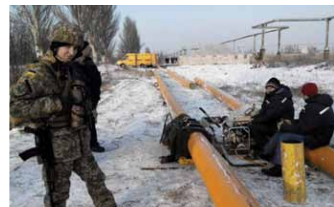
Роботи з відновлення електро-, газо- та водопостачання на території проведення антитерористичної операції.
