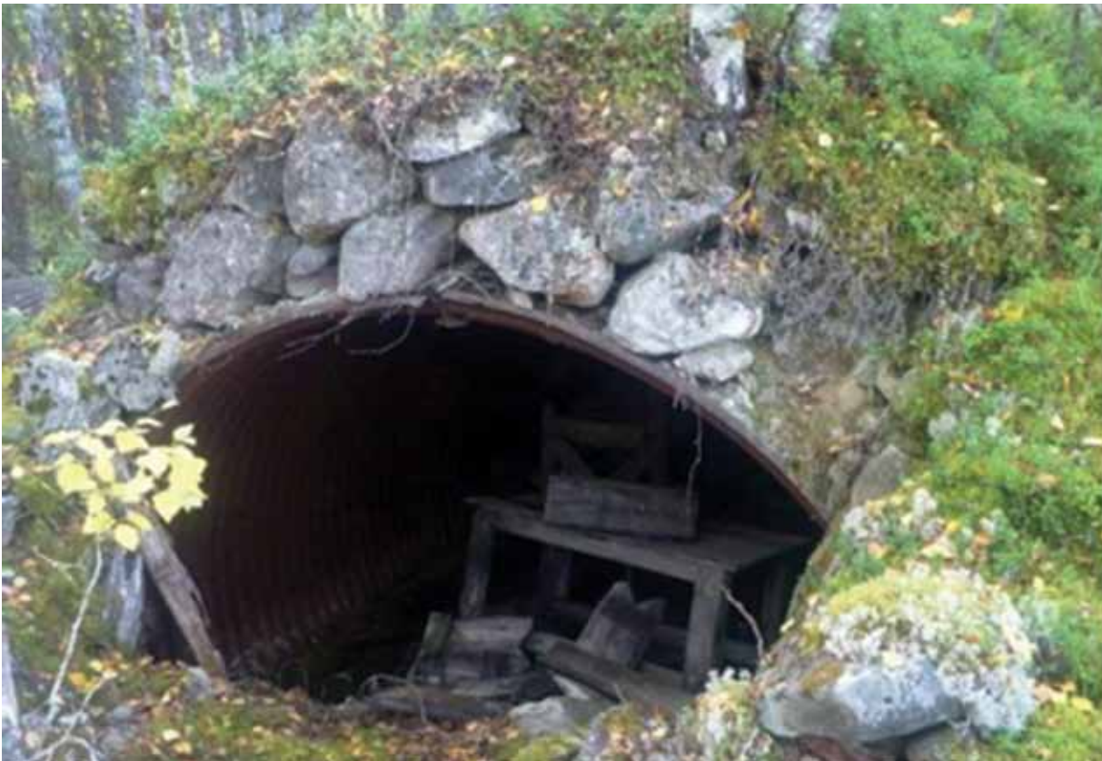
Фото 14. Типове сховище з аркових секцій хвилястої (гофрованої) сталі, застосовувалося в роки Першої та Другої світових війн. (Фото з мережі Internet)
