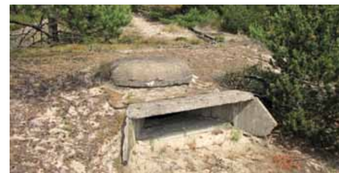
Фото 11. Залізобетонний ковпак польського виробництва 1960-70-х рр. з зовнішнім розтрубом амбразури. Фото Alkali
