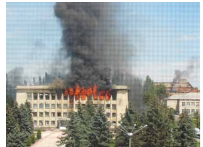
Будівля Дзержинського міськвиконкому у вогні-бій триває!
